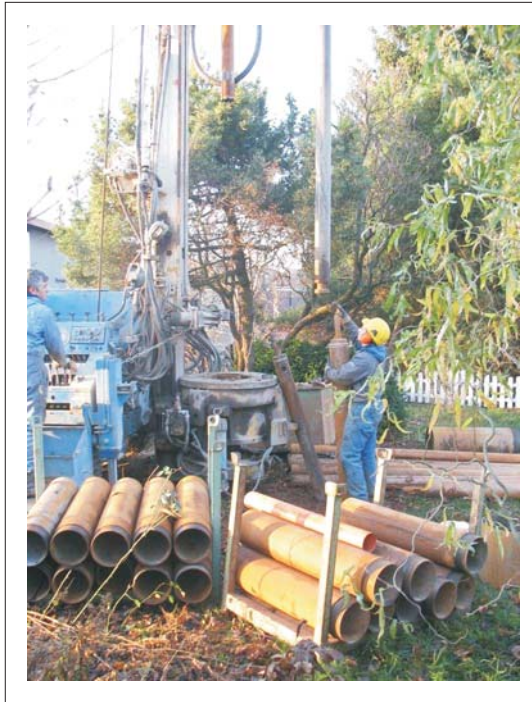
Bild 5: Durchführung der Bohrung mit durchgehender Gewinnung gekernter Proben zur Erkundung der Karstausbildung im Osten, 02.12.2009
