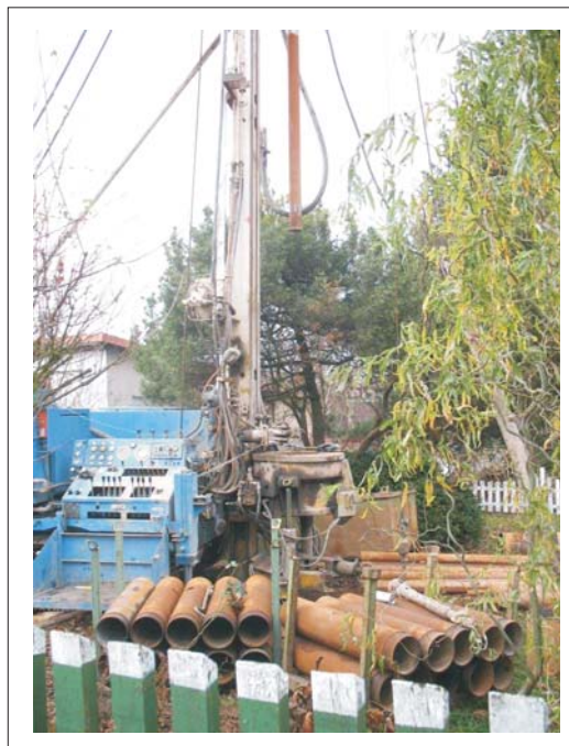
Bild 4: Durchführung der Bohrung mit durchgehender Gewinnung gekernter Proben zur Erkundung der Karstausbildung im Osten, 02.12.2009
