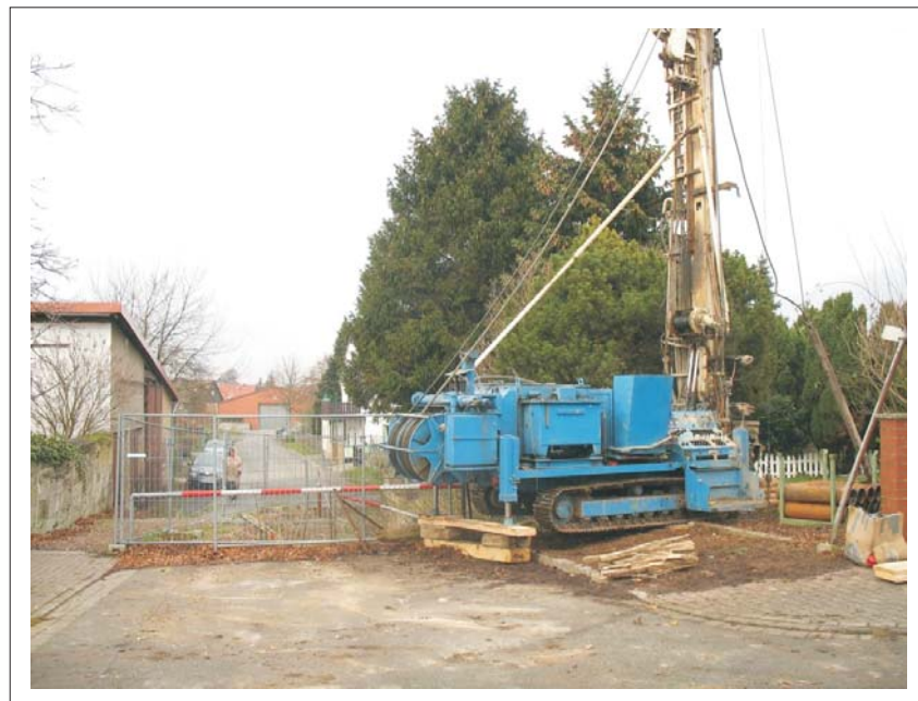
Bild 2: Durchführung der Bohrung mit durchgehender Gewinnung gekernter Proben zur Erkundung der Karstausbildung im Osten, 02.12.2009
